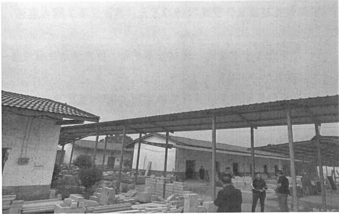
古南桥村楼雷岑建材厂闲置屋面
